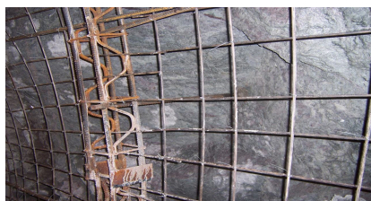
(c) K1+920 段 \phi 8 mm 钢筋网
