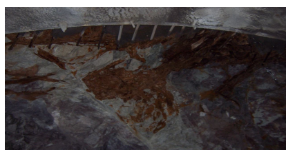
(a) K1+920 段长 4.5 m 岩体部分超前小导管
